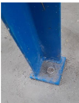
Obr.5 Kotvení k podlaze
