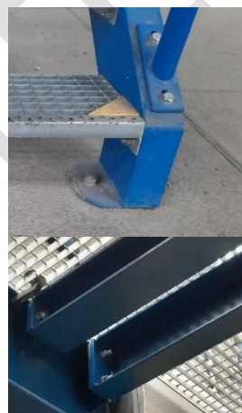
Obr.3 Kotvení schodišť
