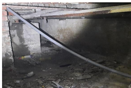
Obr.11 Odpadní potrubí z umyvadla
