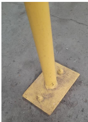
Obr.8 Kotvení tabule
